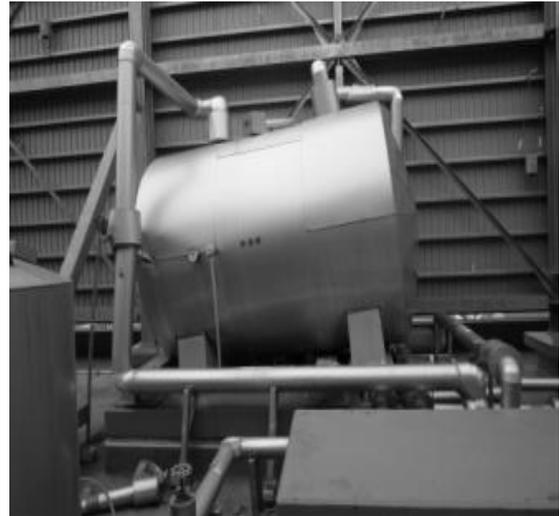
写真4 横型貯湯槽脚部の座屈による傾斜
