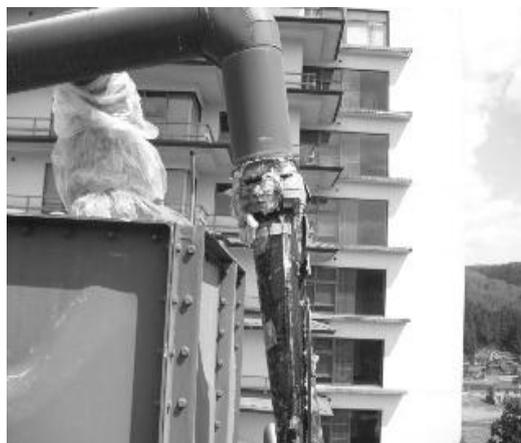
写真1 高置水槽周辺の揚水管継手部の破損
