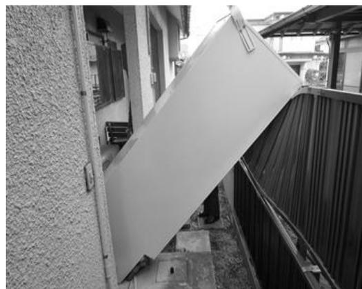
写真2 家庭用ヒートポンプ給湯機用タンクの転倒
