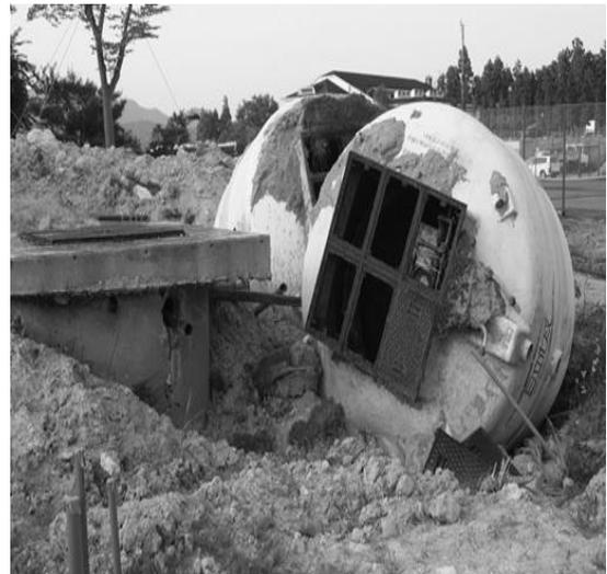
写真5 法面崩壊による沈殿槽の浮上り転倒
