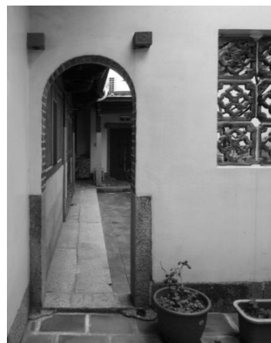
中庭のさらに奥にある居室への通路
