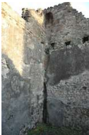
VI.i.30 二階トイレと排水管
