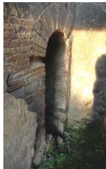
一階のトイレ・ニッチ
