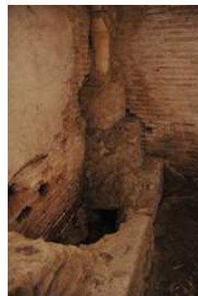
台所トイレ跡と排水管
