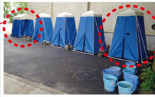
▲体育館裏に設置されたマンホールトイレ。中は洋式。5基中1基は車椅子対応型。排泄後の流下用と思われる用水もバケツに用意されている。
