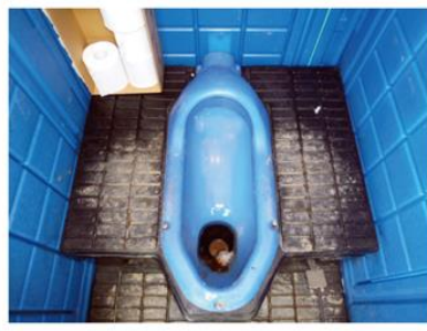
▲和式型の仮設トイレ
