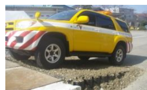
災害時段差スロープ設置工法
