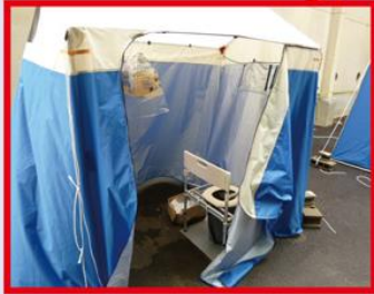
▲体育館裏に設置されたマンホールトイレ。中は洋式。5基中1基は車椅子対応型。排泄後の流下用と思われる用水もバケツに用意されている。
