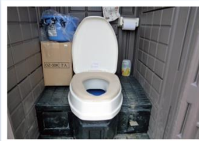
▲和式型の仮設トイレをアタッチメントで洋式化 高齢者を始めとして洋式の要望は多く、既存の和式型仮設トイレを洋式化するアタッチメント用品が活躍している。洋式化後のトイレトペーパーの位置に工夫を期待。
