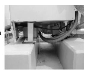
写真3 家庭用ヒートポンプ給湯機用タンク脚部の仮復旧
