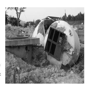
写真5 法面崩壊による沈殿槽の浮上り転倒
