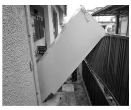
**写真 2** 家庭用ヒートポンプ給湯機用タンクの転倒
