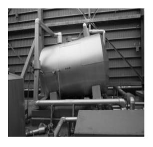
写真 4 横型貯湯槽脚部の座屈による傾斜
